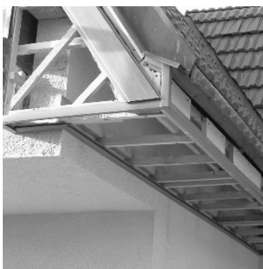
osazené ukončovací profily a 1. lamela
